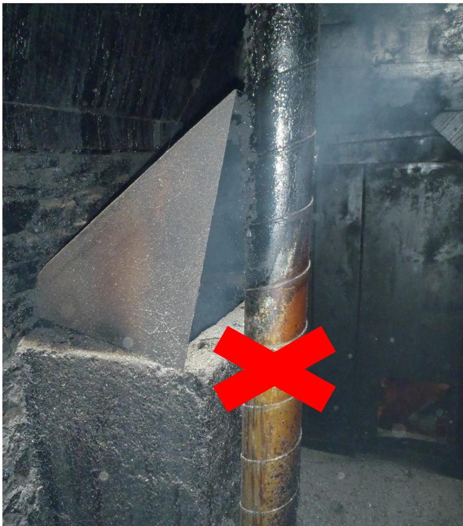
5. Der Deckel des Holzkamines muss fachgerecht, aus Massivholz oder nichtbrennbarem Material erstellt sein.
