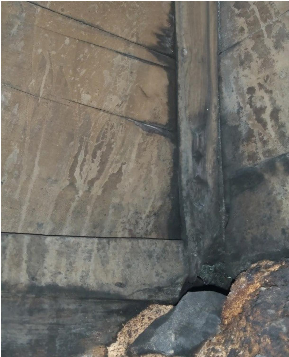
2. Holzkamine sollen aus mindestens 45 mm starken, gehobelten Brettern - mit Nut und Feder oder Nut und Kamm - luftdicht gefügt sein. Die Ausführung der Fugen erfolgt gemäss Vorgabe auf der Seite 7.
