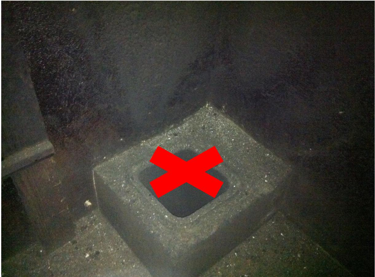
11. Rauchkammern können am Kaminfuss durch einen Betonboden abgeschlossen werden. Ist der Boden aus Holz, so muss er mit einem mindestens 6 cm starken Zementüberzug versehen sein.
